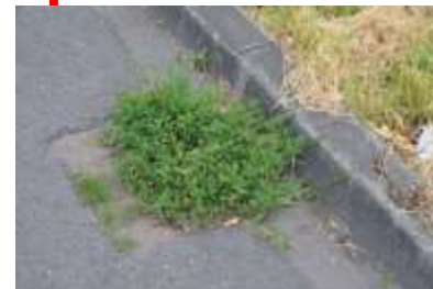
Letzter Gully, teilw. geteert, ungeöffnet, ungereinigt
