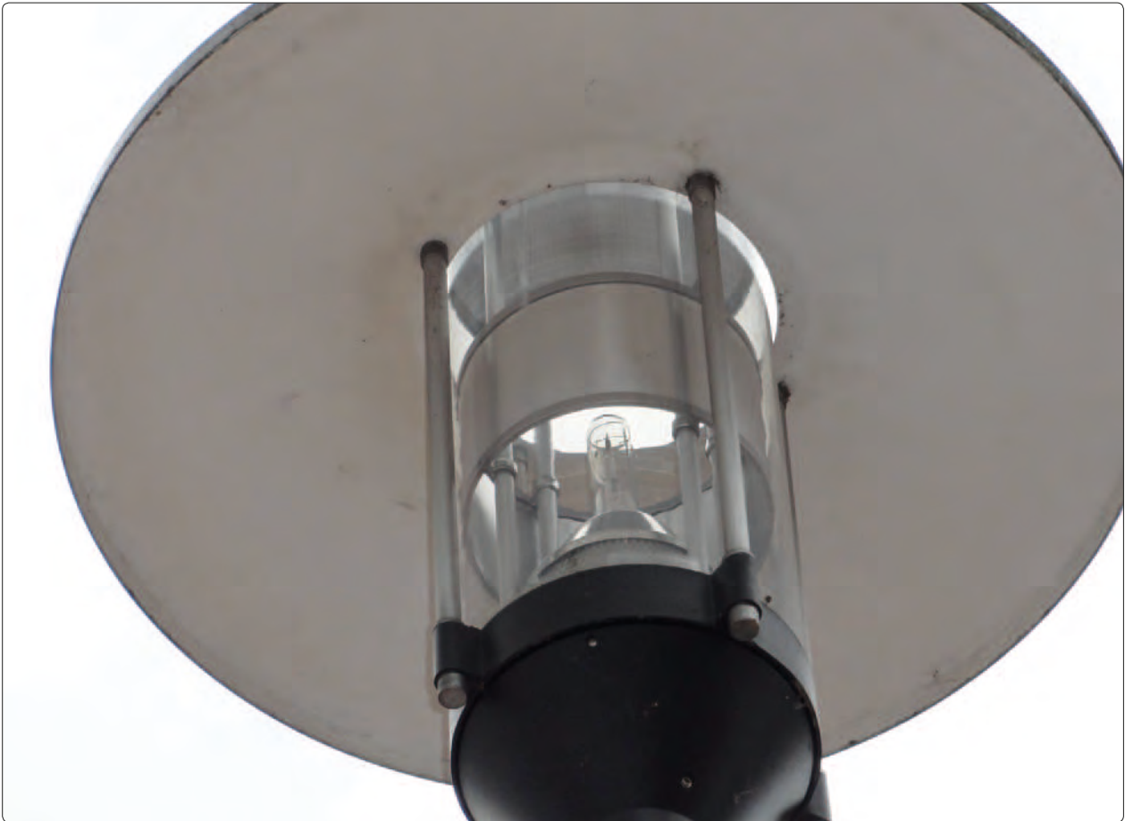
7.3 // Effiziente Hochdrucklampe mit Blendungsreduzierung im Detail – Leuchtenbetriebswirkungsgrad: 55%
