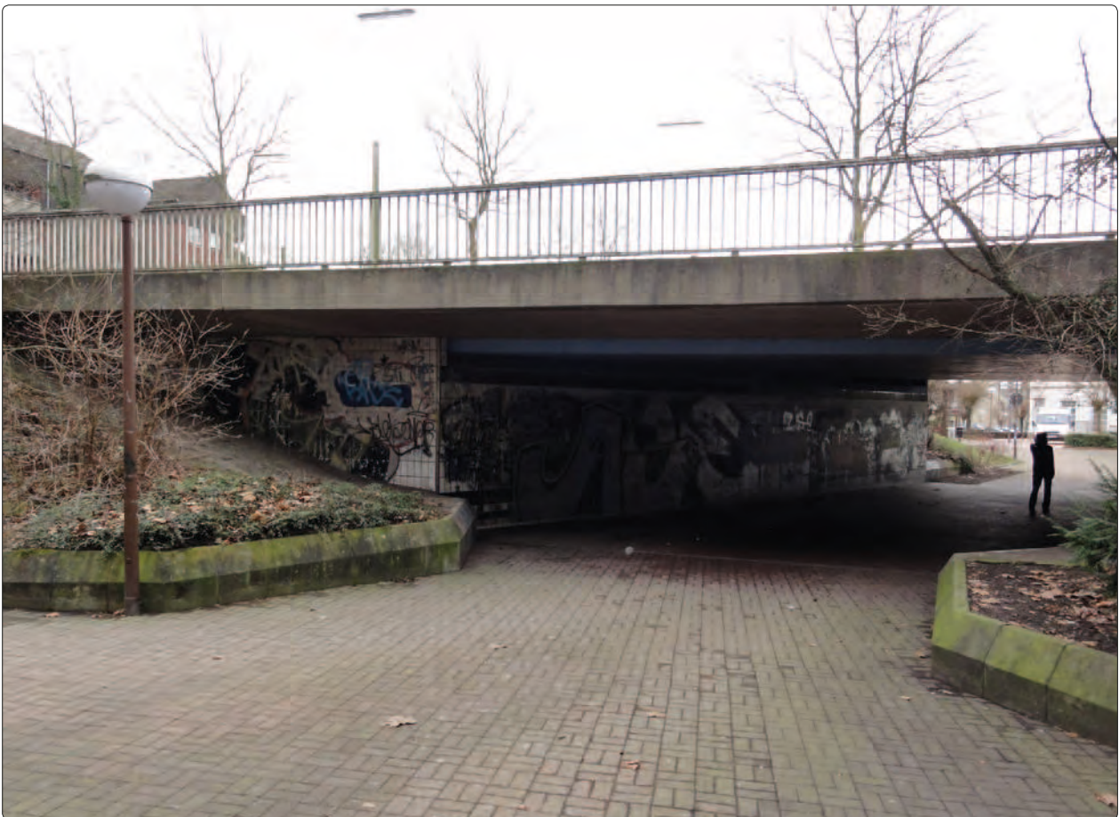
7.15 // Unterführung 'Obere Münsterstraße'
