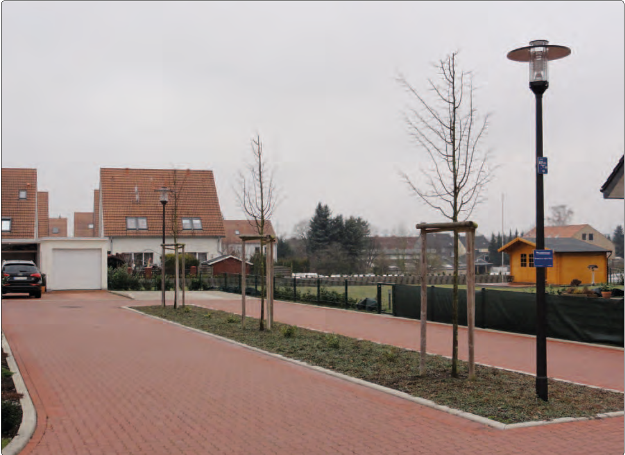
7.10 // Beleuchtung einer Privatstraße
