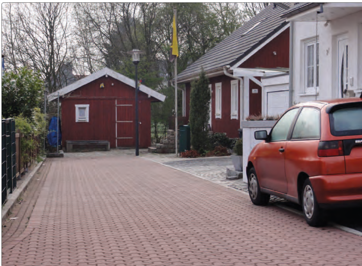
7.13 // Beleuchtung am Ende einer kurzen Stichstraße
